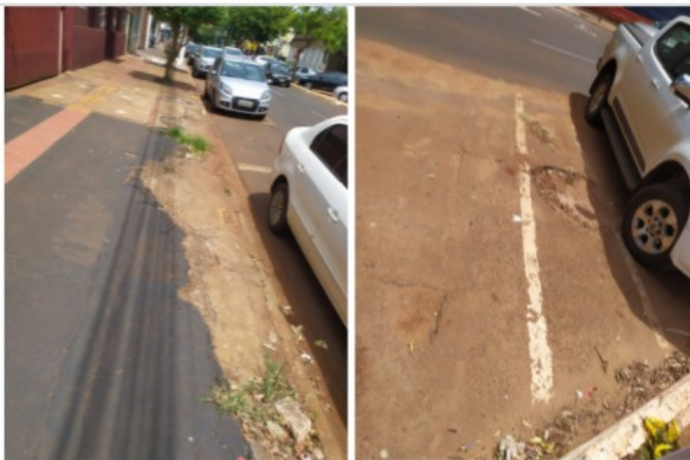
Avenida Weimar Gonçalves Torres com Rua João Rosa Goes (dia 14/02 às 10h30min)
