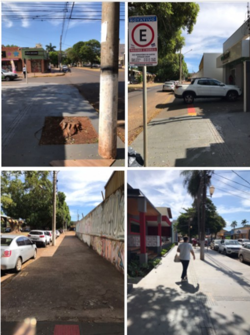
Rua João Cândido Câmara com Rua Oliveira Marques (dia 25/02 às 9h)
